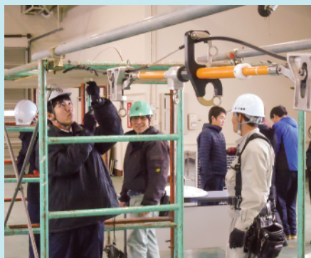
電気工事体験交流会(道北電気工事組合格)
