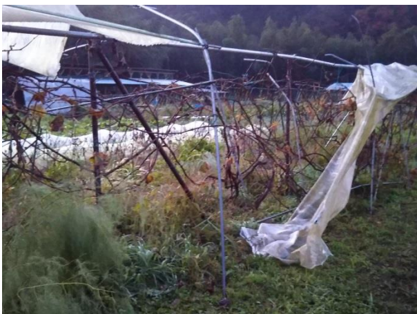
写真6 ブドウにかけた雨除けビニールの破損
