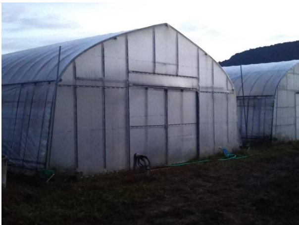
写真4 イチゴ用ビニールハウス外観
